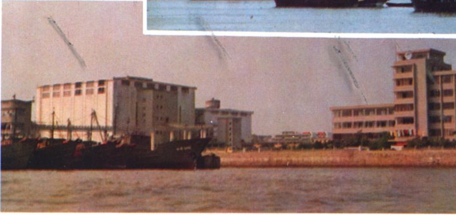
汕头海洋渔业公司 办公楼及冻厂、码头
