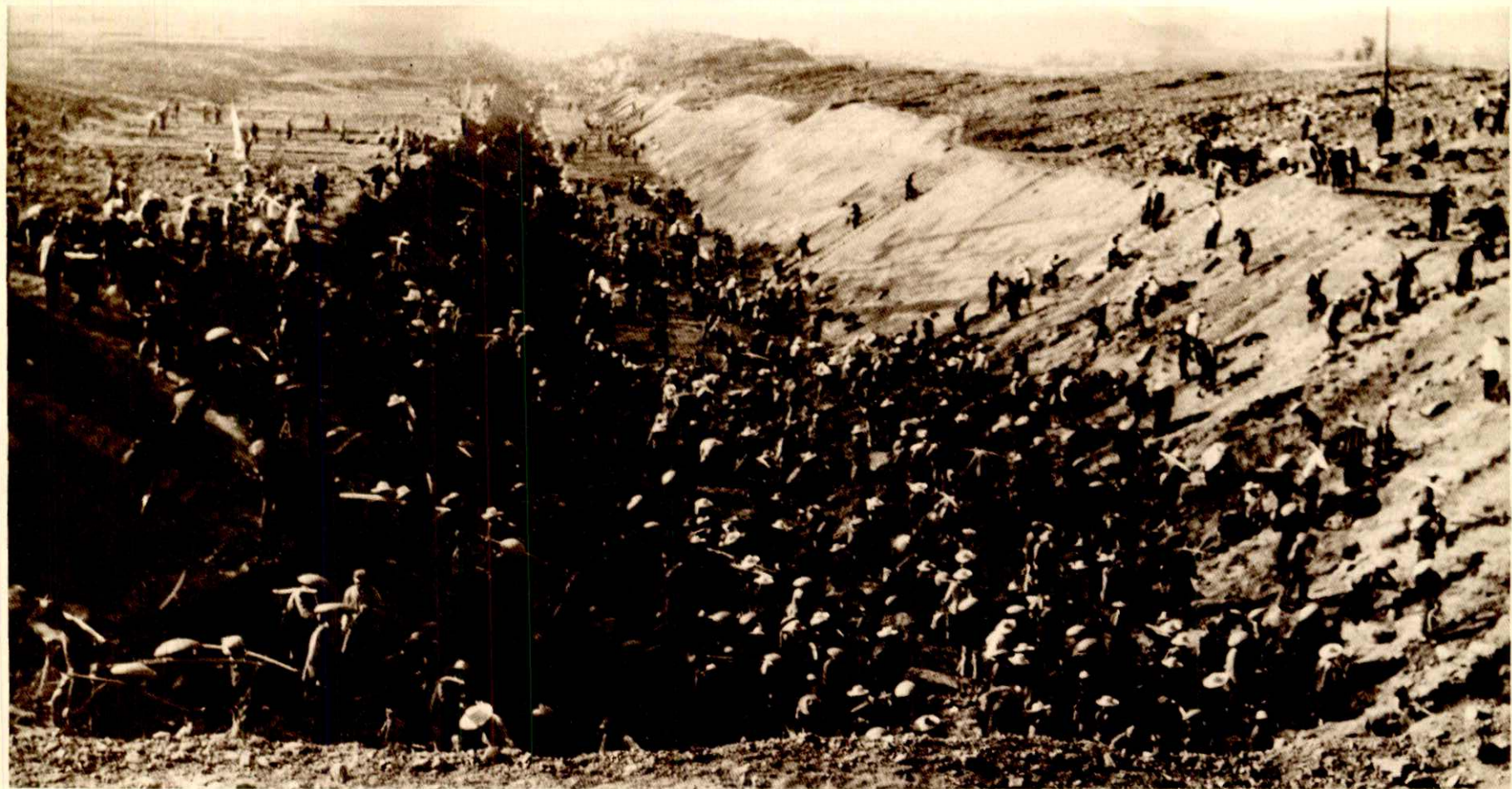
铁路专用线施工
