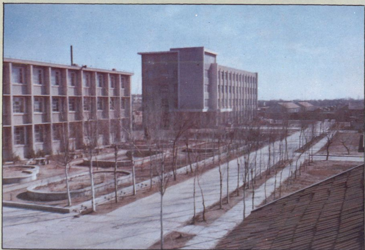
山东省制盐工业科学研究所科研大楼
