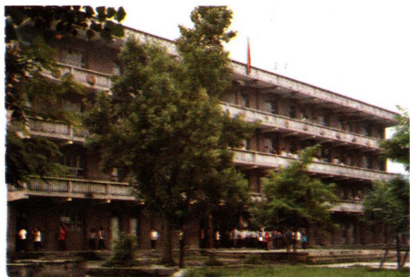
旁海中学教学楼
