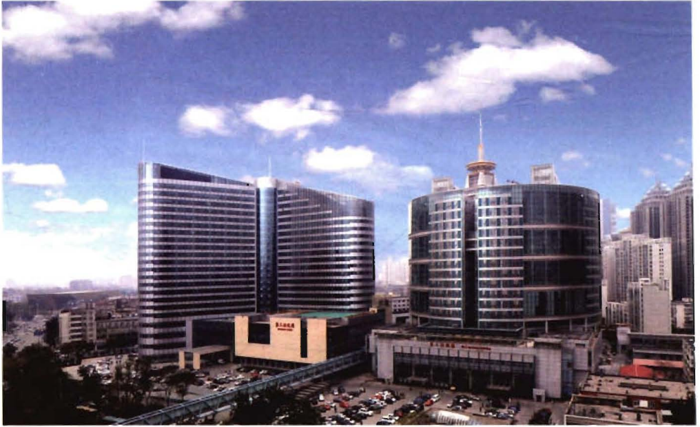
2011年,医学中心二期工程第三住院楼(左)投入使用
