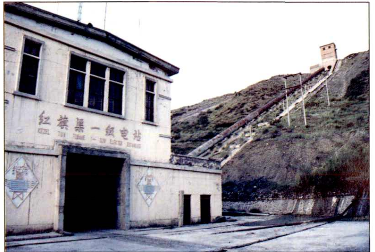
沙湾县红旗渠一级电站
