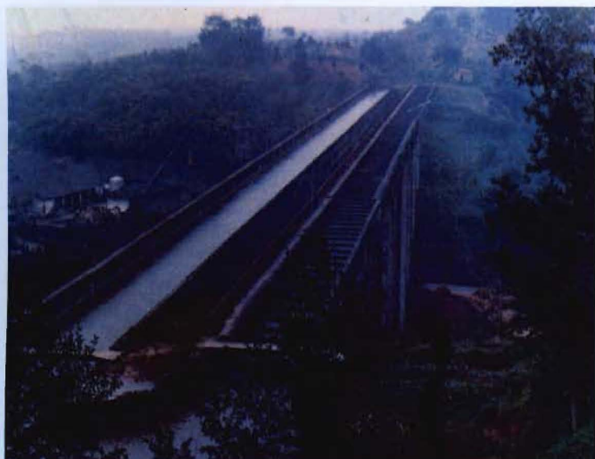
▲ 东风渠鸡公嘴大渡槽
