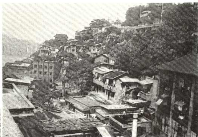
临江门一带的旧式房屋建筑
