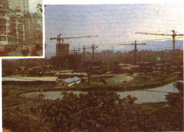
建设中的重庆经济技术开发区—南岸南坪
