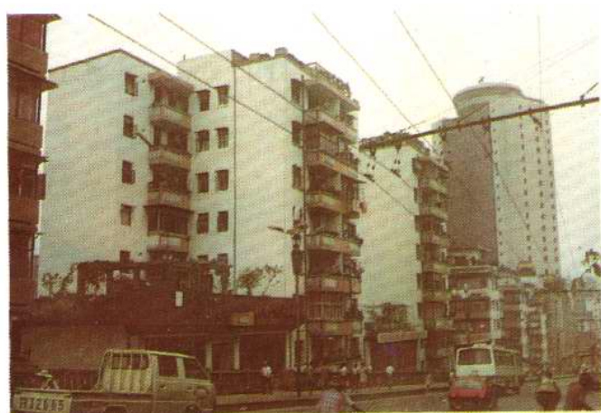
新辟的中三支路侧的建筑群
