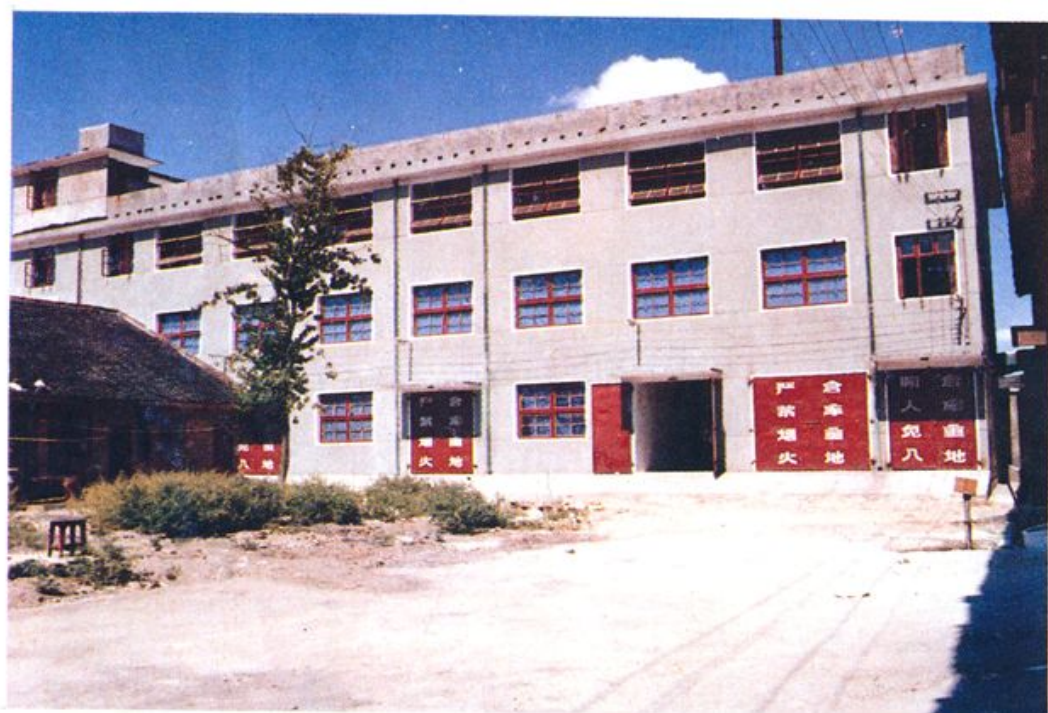
图 4 桃源县药材公司(中药仓库)
