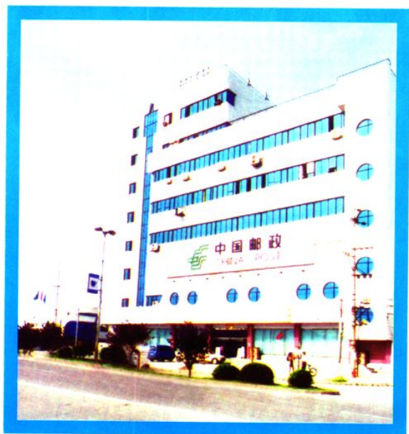
● 市邮政储汇局办公楼（江津中路214号）
