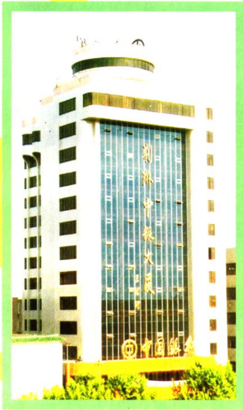
● 中行荆州分行办公楼（黄金堂路26号）
