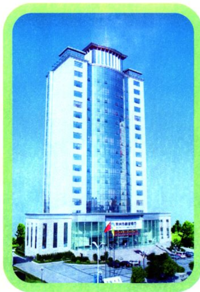
● 市商业银行办公楼 （江津西路68号）
