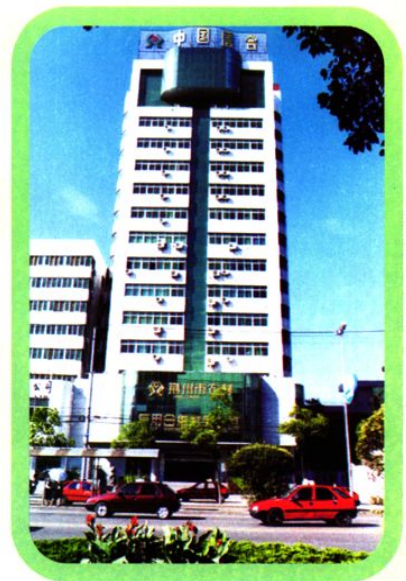
● 市信用联社办公楼 （江津中路255号）
