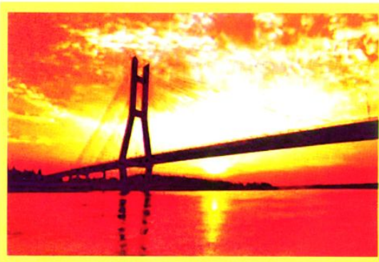
● 晨曦中的仙桃汉江公路大桥——建设银行作为主要贷款行新建的固定资产交通项目。该大桥是汉江上的第18座大桥,为独塔双索面PC斜拉桥,长1.478公里,双向4车道。大桥于2001年1月18日动工,2003年12月28日通车。大桥总投资2.29亿元,贷款1.5亿元,其中建行荆州分行所属仙桃市支行签署为期13年、金额为1.2亿元的基本建设贷款协议,实际发放0.9亿元。
