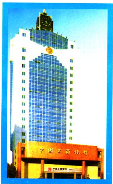
● 工行荆州分行办公楼 （北京中路352号）
