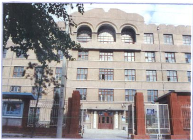
内蒙古自治区地震局旧办公楼
