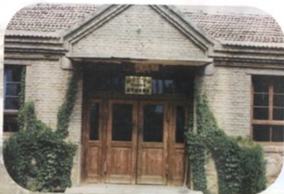
东升庙地震台全貌
