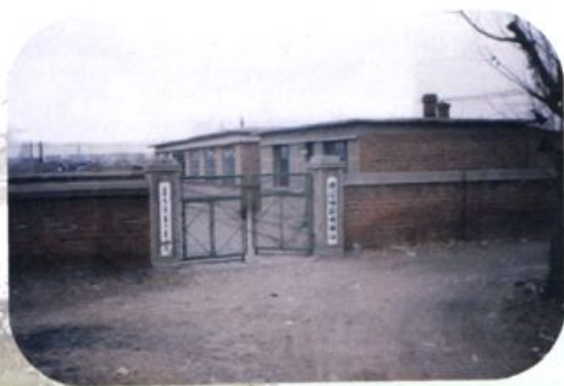
通辽地震观测站全貌
