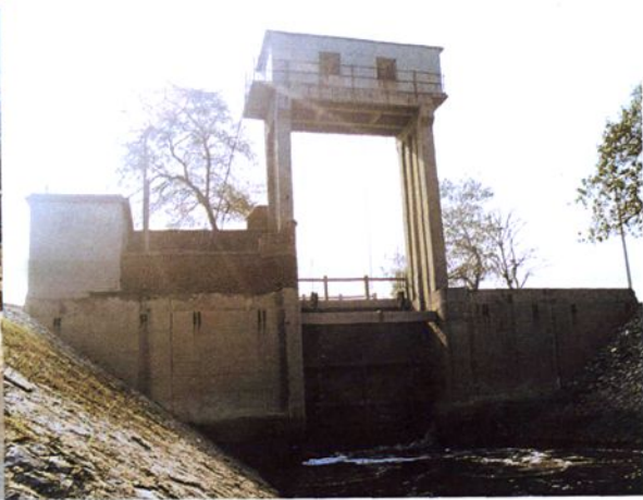
▲ 滏阳河张庄桥节制闸
