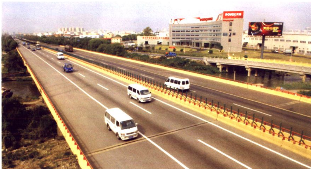
沪杭高速公路中山街道段
