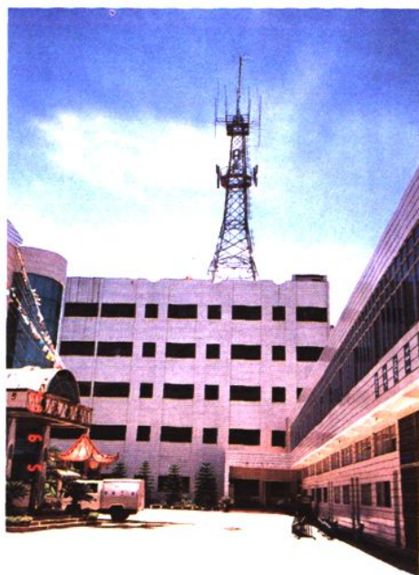
忻城县电信大楼
