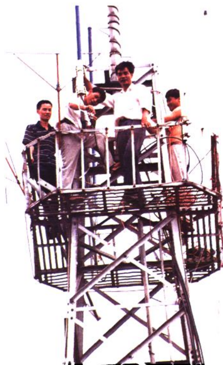
工程技术人员在无线铁塔上工作
