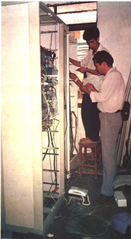
技术人员在调测线路
