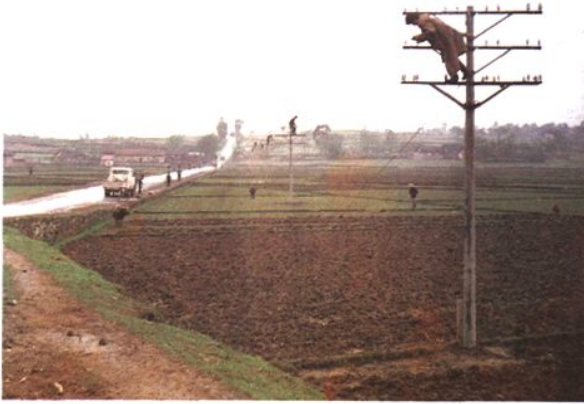
机线员维修通信线路
