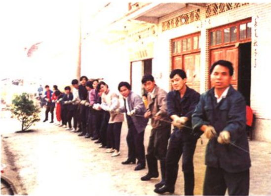
为程控电话早日开通, 男女职工为敷设地下电缆 出大力
