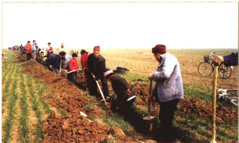
◀ 1997年初,阜毫沿线群众齐上阵,埋设安徽北环阜阳自愈网通信光缆线路。
