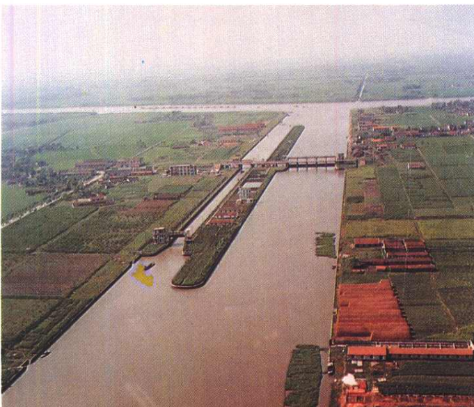
松江县塔汇乡油墩港 农田水利工程
