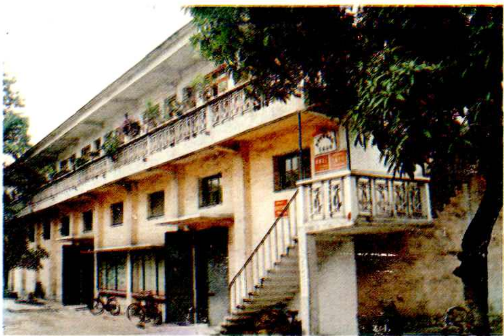
市粮食局大米厂办公大楼(现改为粮油食品工业公司)
