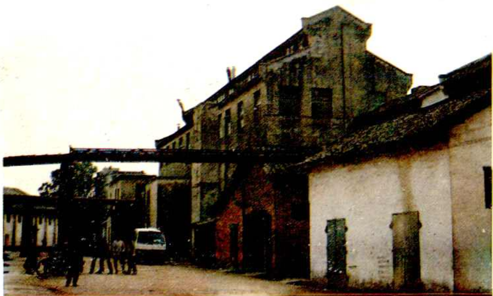
市大米厂是我区大型粮油加工企业,图为大米车间。
