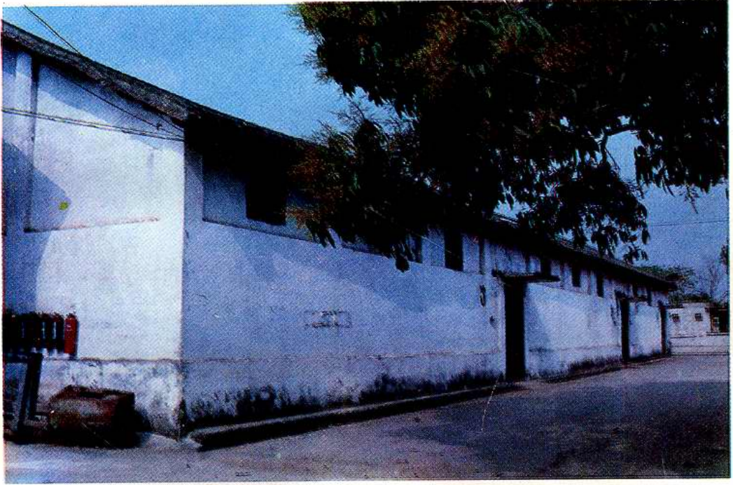
东津粮管所仓库一角
