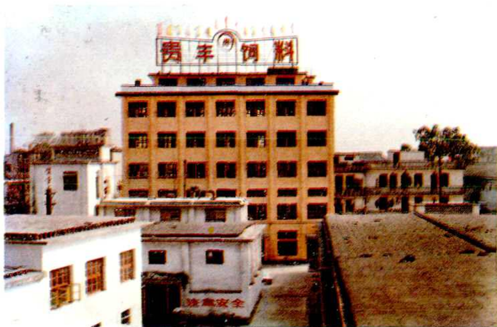
市饲料公司饲料生产线大楼
