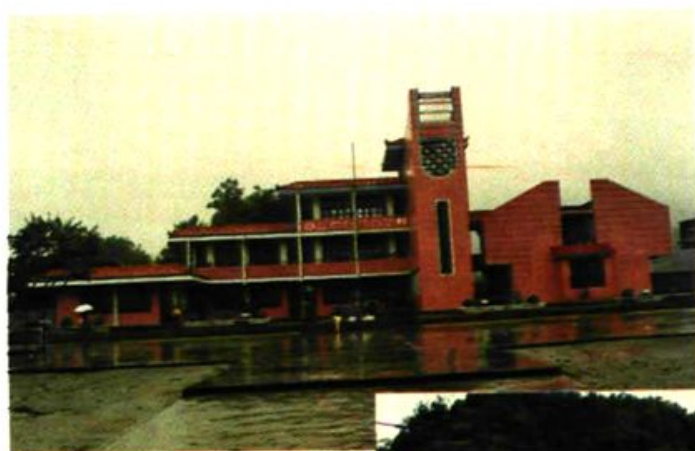
鹤峰县民委投资建设的走马官仓小学教学楼
