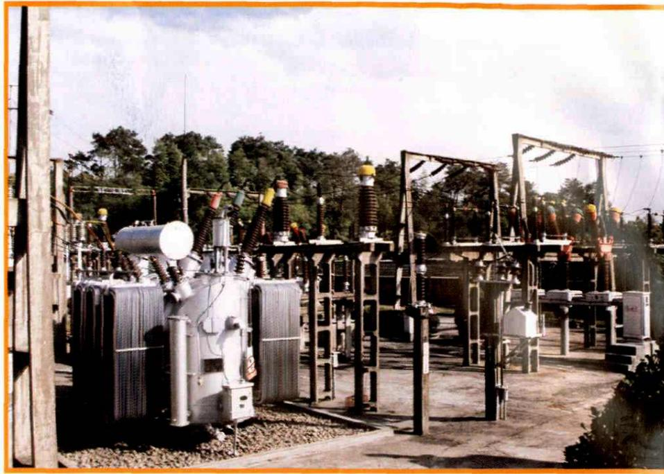
容量为 31500 千伏·安的 110 千伏余姚变电所 1 号主变压器
