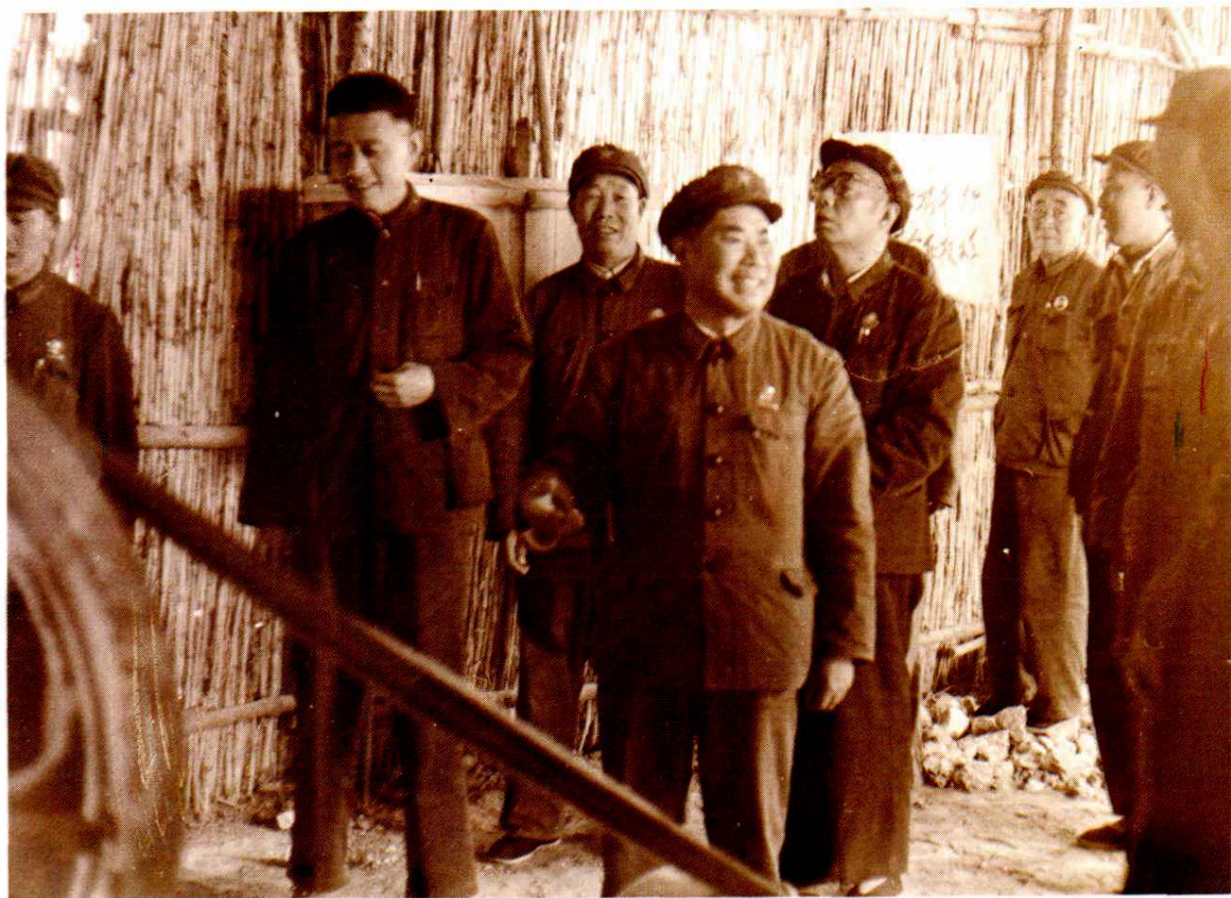
杨得志同志在莱钢工程现场视察（1970年5月21日）
