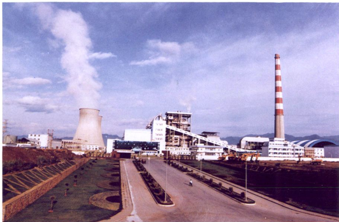
连州发电厂装机容量 2 \times 12.5 万千瓦(1999年建成)
