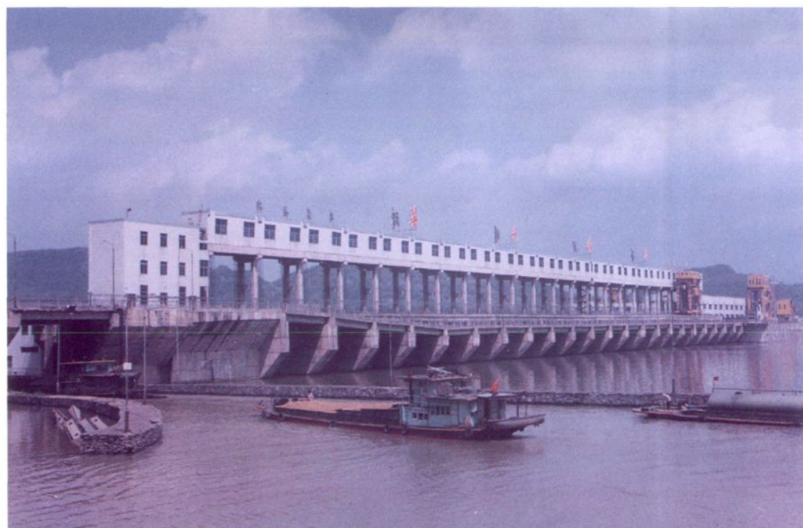
英德市白石密水电厂装机容量 4 \times 1.8 万千瓦(1999年建成)
