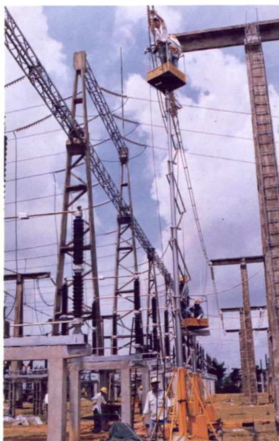
220千伏清远变电站架空母线检 修(1996年7月)
