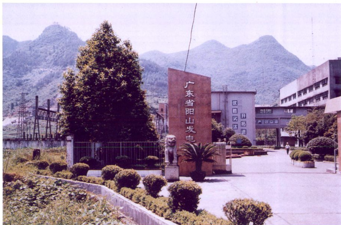
阳山发电厂装机容量 2 \times 2.5 万千瓦(1991年建成)
