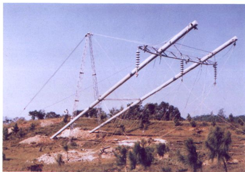
110千伏清龙线线路T 杆整组起立(1993年)
