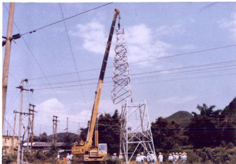
110千伏龙白线铁 塔吊装(1996年9月)
