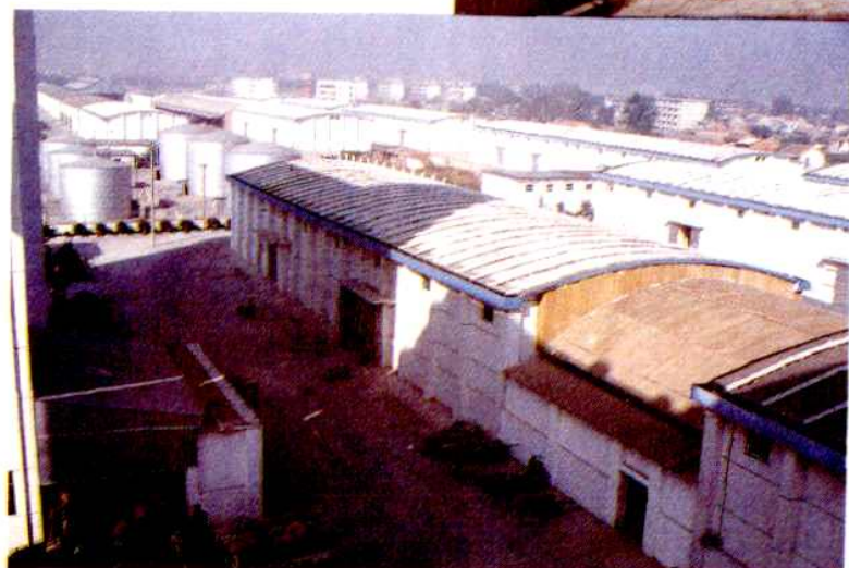
宿州国家粮油储备库一角，近为粮仓、远处圆形立筒为油罐。
