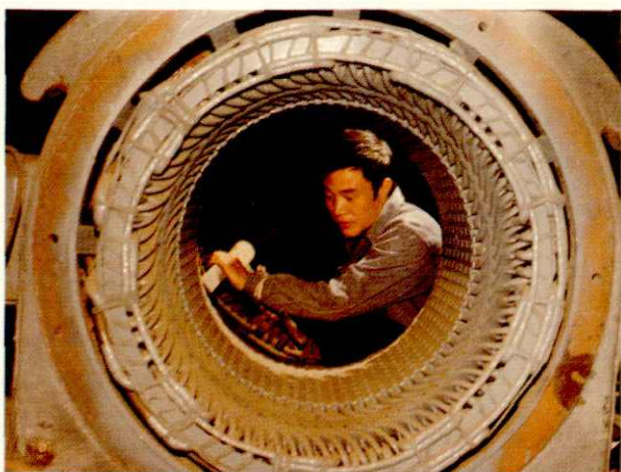
电气分厂修理高压电机
