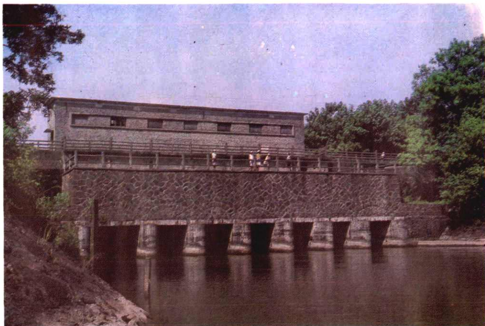
东干渠柴埠口进水闸
