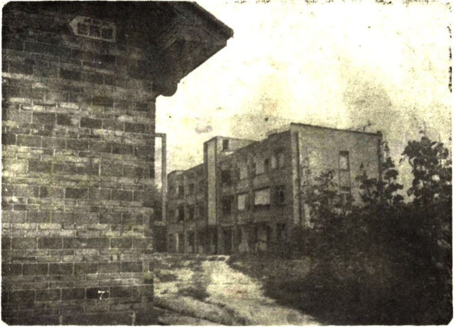
大足县万古精神病医院住院部 (1985年建成投入使用)
