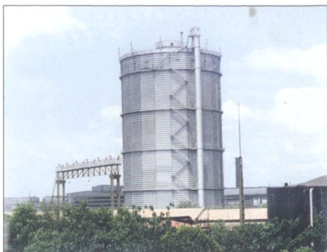
十万立方米高炉煤气柜。
