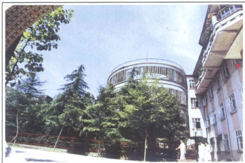
职工医院外科大楼。
