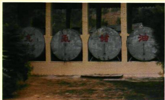
上世纪70年代使用的充氮储油罐
