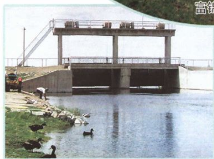
二道岗滞洪区
