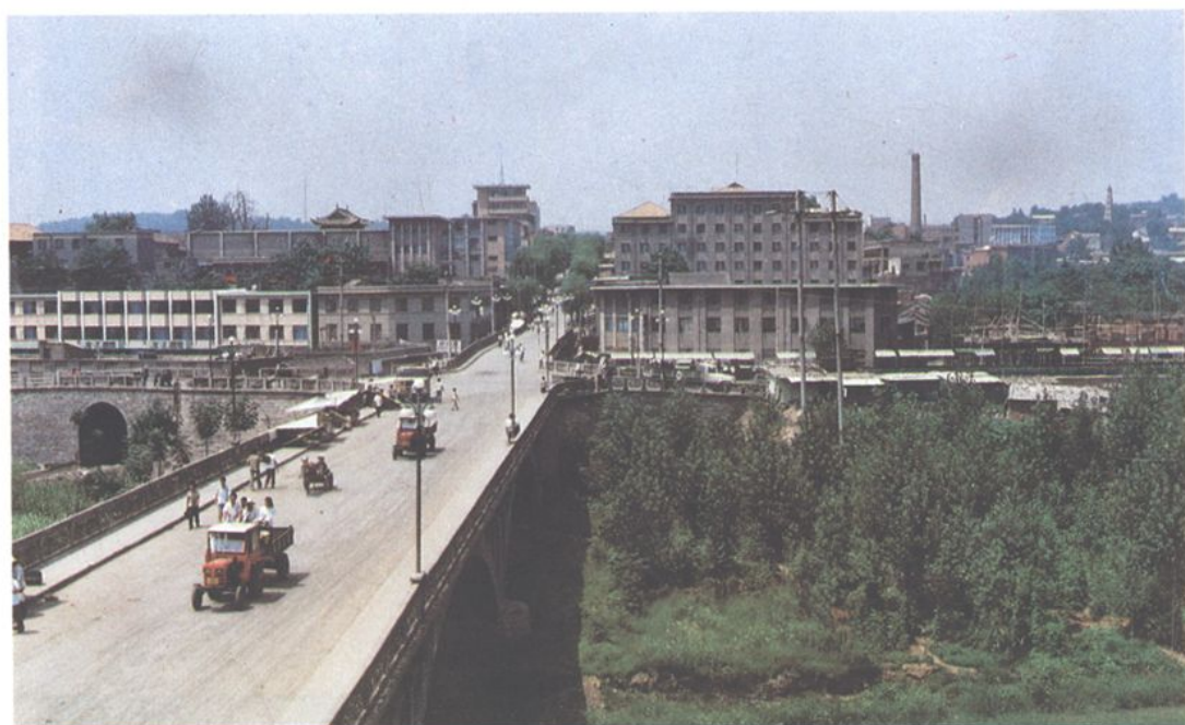
阳城县东河大桥
