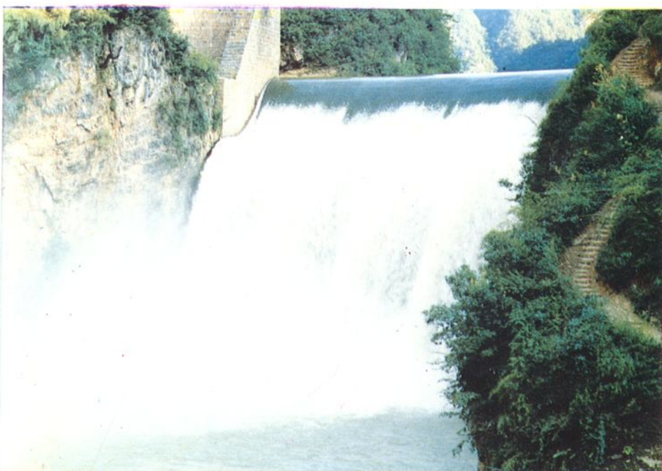
下阳日大坝 张应世 摄
