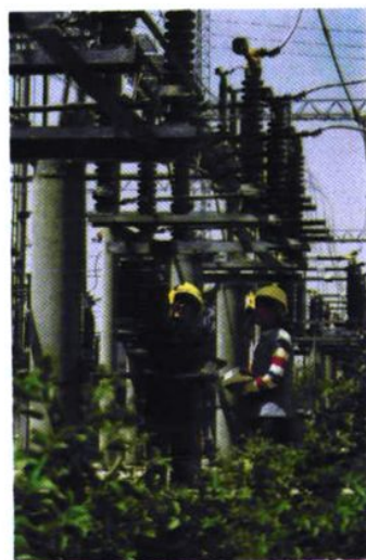
变电运行操作
