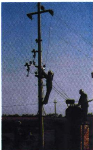
配网线路维修
