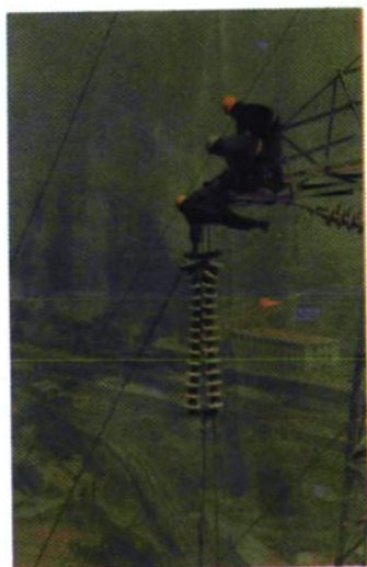
220 千伏输电线路检修
