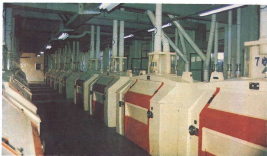
▷ 沛县面粉厂制粉车间
