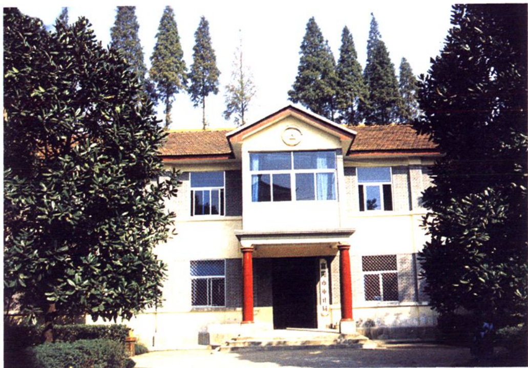
▲ 富阳市审计局办公楼
