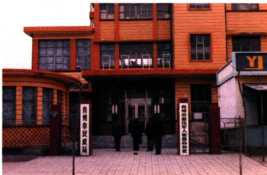
青州市民政局办公楼外景
