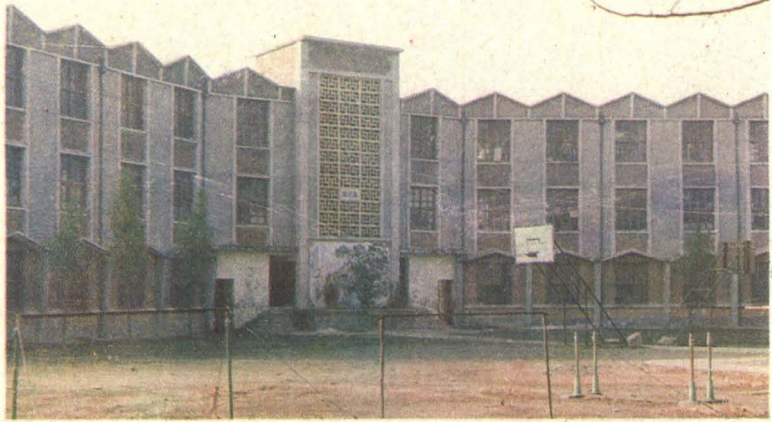
汝南园林学校 学生宿舍楼
