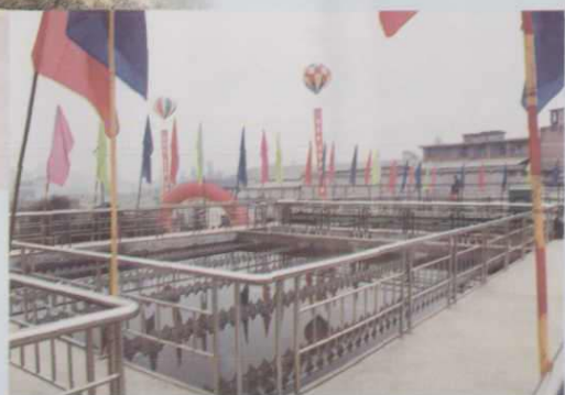
城市三万吨供水工程一角
