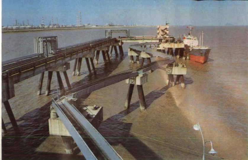
上海石化总厂化工码头
