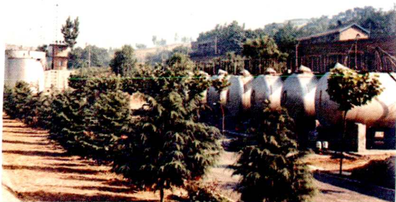
散装卧式油罐设施
