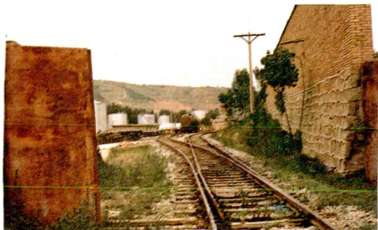
油库铁路专用线
