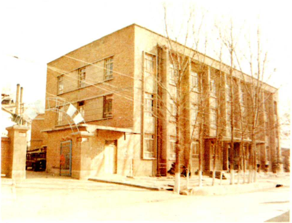
陕西省石油公司铜川分公司办公楼
