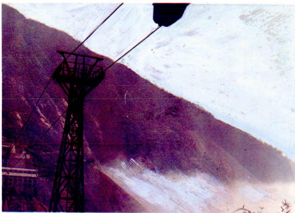
▲ 瑶岗仙钨矿索道
