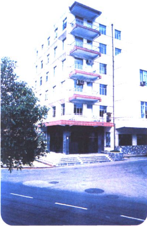
技术大楼外景
