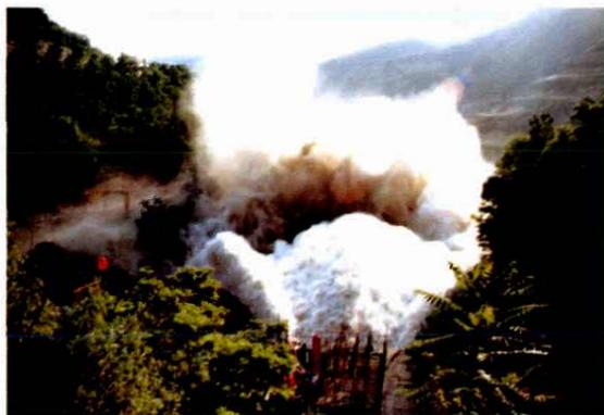
▲ 2002年5月，泄洪洞出口闸门改造后泄水试运行
