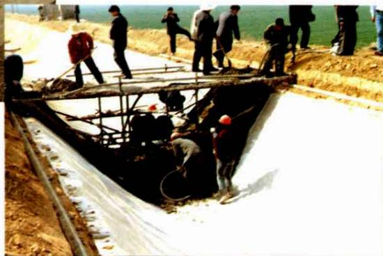
▲ 2000年灌区改造中，冯家山水利水电工程公司在南干渠进行弧底梯形渠道滑模施工
