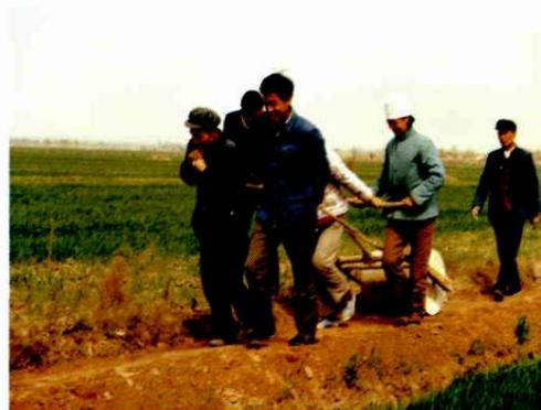
灌区配套设施施工中渠道土方碾压
