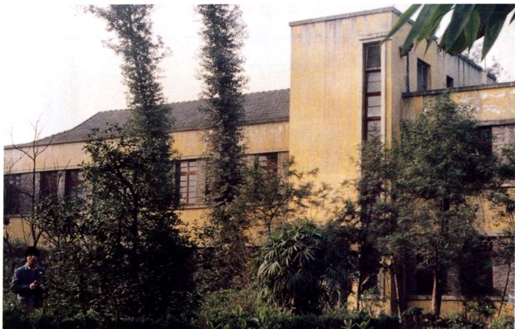
学校原办公楼
