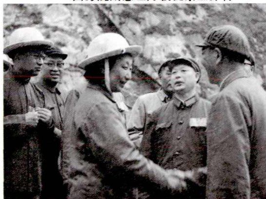
国务院水电部部长钱正瑛视察石砭峪水库
