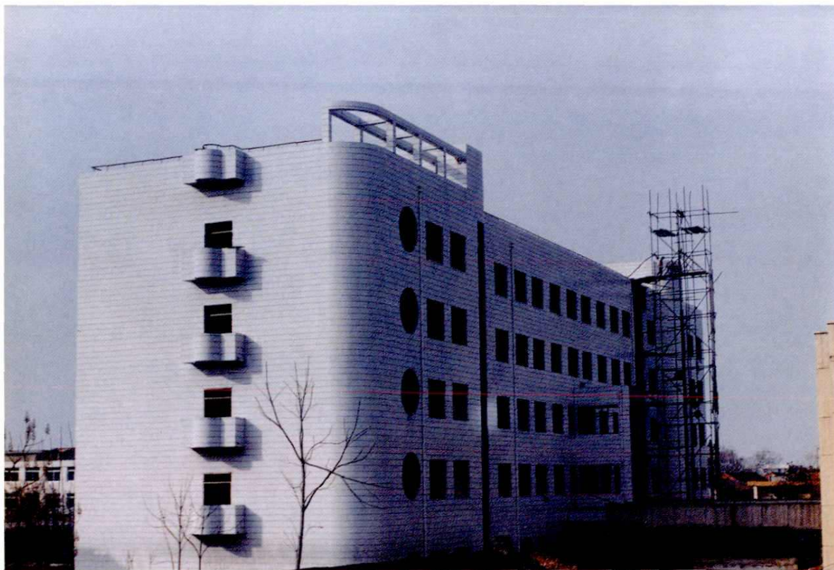
正在建设中的县医院病房楼
