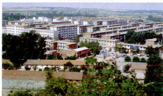
韦曲镇青年南街住宅小区
