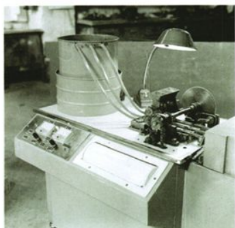
国光一直以来秉承自力更生艰苦奋斗的作风，不断进行技术革新技术改造，图为七十年代，自行设计和制造了中周打印机。七十年代自行设计和制造中周外壳冲孔切边多工位冲床。
