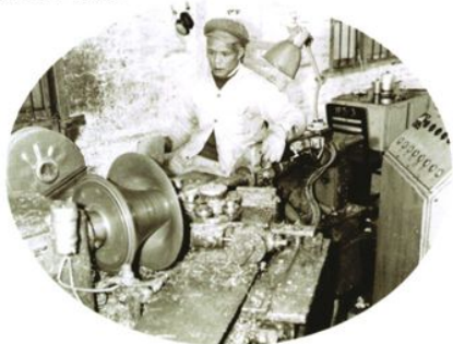
六十年代，扬声器底座出模后对其表面打磨修饰的工作场面。
