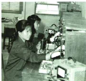
七十年代，职工李秀珍在测试中周变压器。
