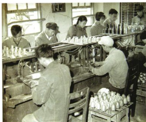
六十年代，扬声器底座出模后对其表面打磨修饰的工作场面。
