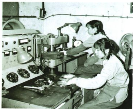
七十年代，职工许励华（右一）操作注塑机生产中周塑料底座。
