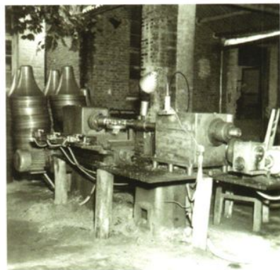
六十年代，自行设计制造的赶床，可生产高音喇叭大号筒和号筒中节。
