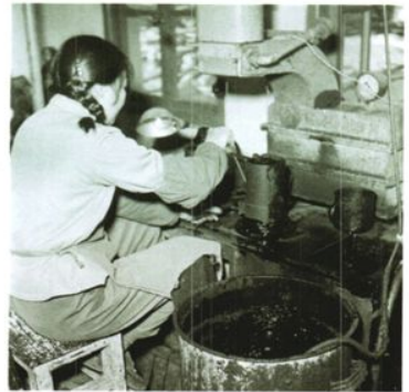
早期的纸盆手动捞浆热压工序。
