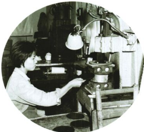
早期的纸盆手动热压工序。
