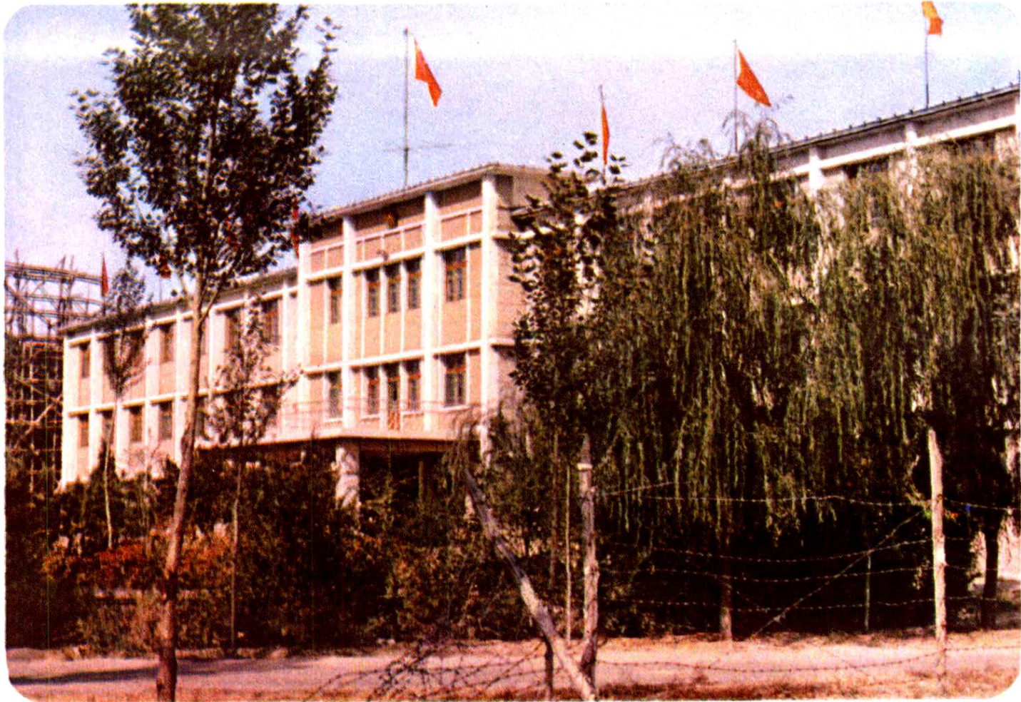
托克托县人民政府办公楼
