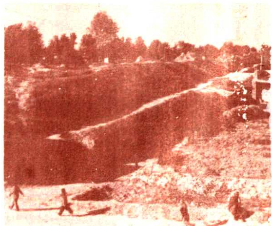
镇鲁卫城一角 图为故城西南一角。
