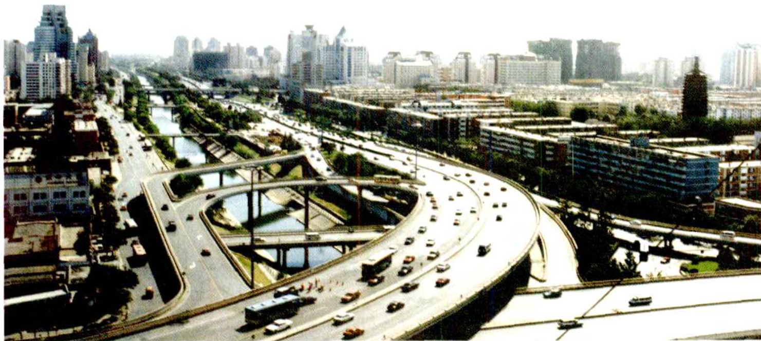
天宁寺立交桥
