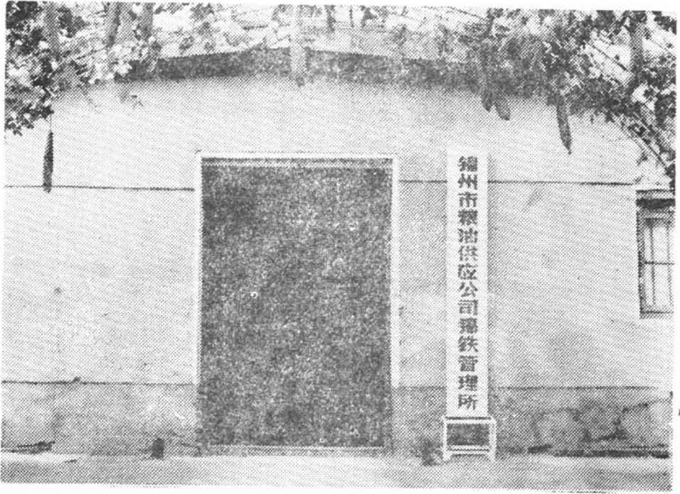
锦铁粮油供应管理所正门
