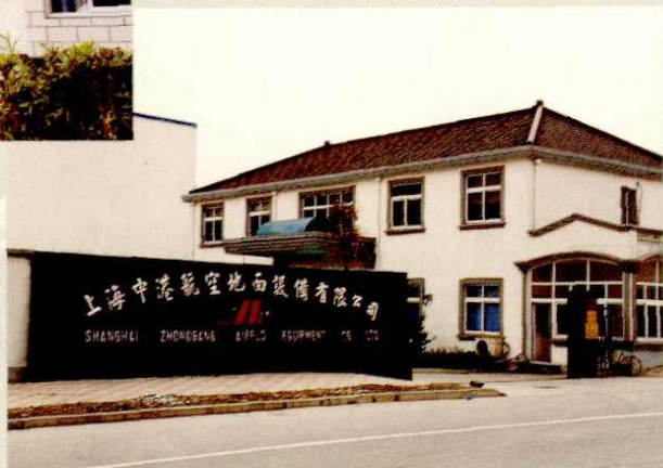
上海中港航空地面设备有限公司。
