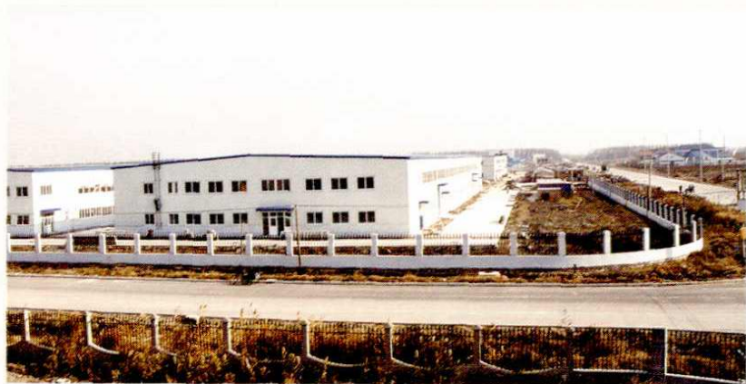
建设中的老港化工园 区。（姚正兴 摄）
