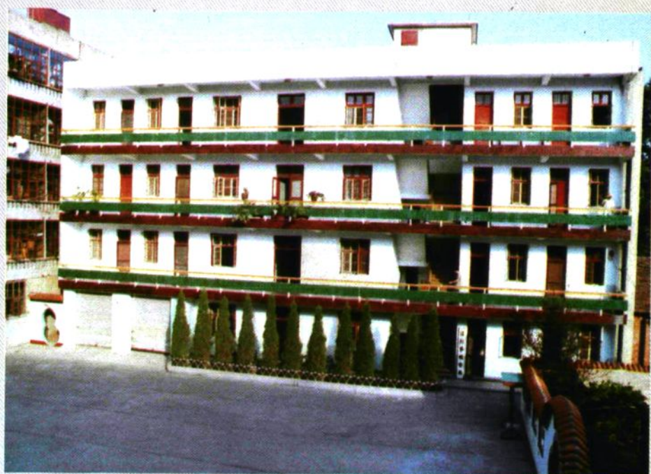
粮食局办公大楼
