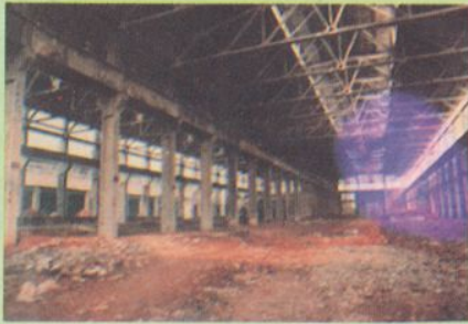
兴建中的厂房
