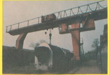
32吨龙门吊正在起运锅炉
